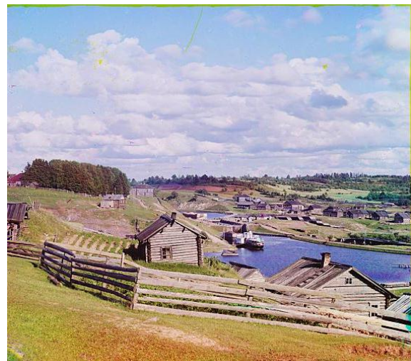
12 Veel opnamen laten de infrastructuur zien, bijvoorbeeld spoorwegen, bruggen of kanalen. Hier de Sint Paul sluizen bij Devyatiny (circa 30 km ten zuiden van het Onega meer), 1909.
